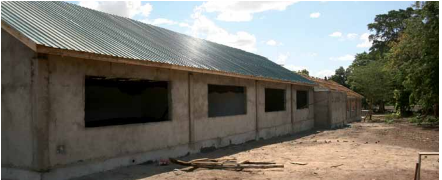
Het 2e schoolgebouw in aanbouw
